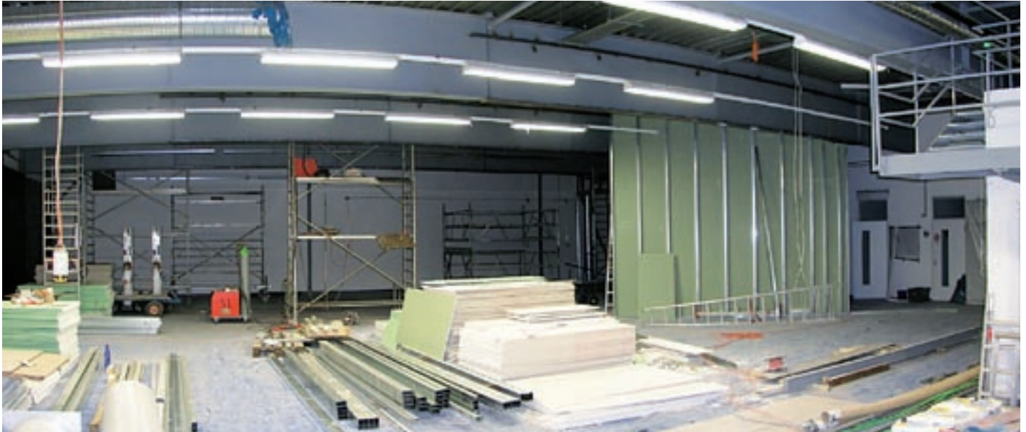
Abbildung 3: Baufortschritt des S3-Labors am 19. März 2007, 1 Monat nach Baubeginn. (Foto: Frank Obergrießer, Fraunhofer IBMT)
