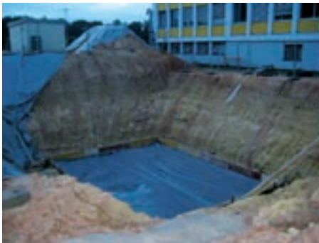
Erdaushub für das Ultraschall-Messbecken.
