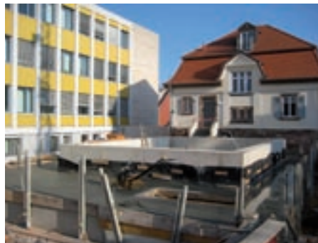
Weitere Impressionen des Baufortschritts.
